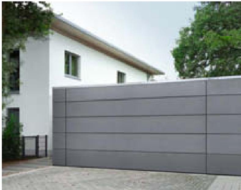
Eingebaut und beplankt ist das Garagentor Teil der durchgehenden Fassadenfront.
